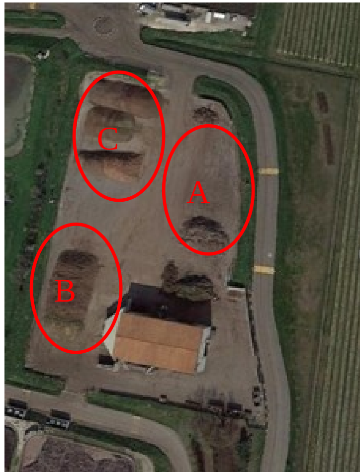
Figura 1: Impianto di tritovagliatura e relativi piazzali
